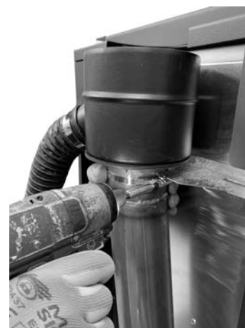
Fig. 48 - Zablokować opaską zaciskową
