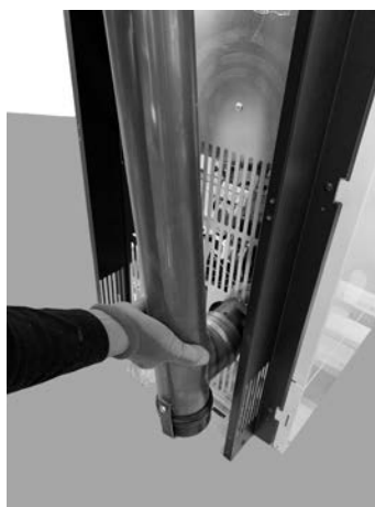
Fig. 47 - Przyczepić rurę o śr. 80 mm
