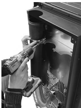
Fig. 63 - Zablokować rurę o śr. 80 mm
