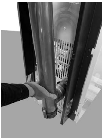
Fig. 41 - Przyczepić rurę o śr. 80 mm
